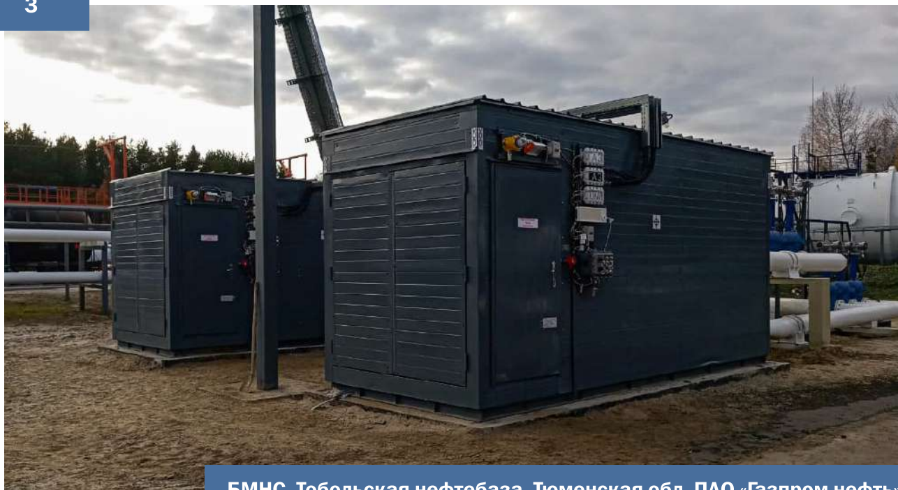
БМНС, Тобольская нефтебаза, Тюменская обл, ПАО «Газпром нефть»
